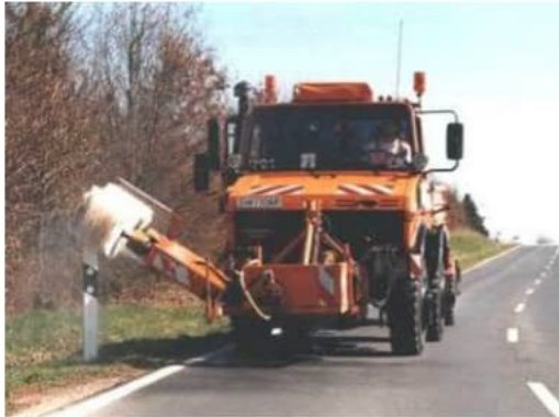
Die Sichtbarkeit der Leitpfosten wird durch regelmäßiges Waschen sichergestellt © Staatsbauverwaltung
