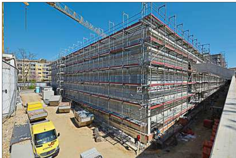
Fenster hin, Fenster her: Der Baufortschritt ist deshalb nicht gefährdet, versichert das Staatliche Bauamt. Derzeit wird vor allem im Inneren gearbeitet. – Foto: Schlegel
