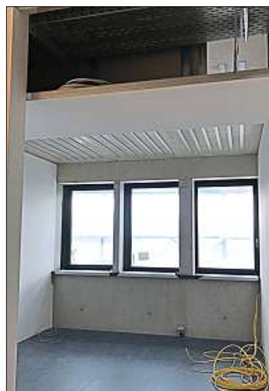
Der Boden ist verlegt , jetzt kommen noch Kabelschächte: Die Räume der Kripo sind am weitesten ge- diehen.
