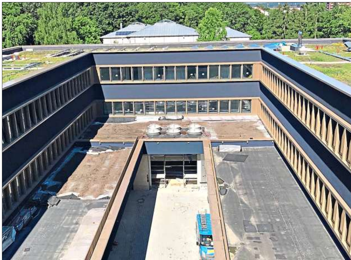
Blick in den Innenhof: Unter den Lichtkuppeln wird das Farbmarkierungsschießen stattfinden, auf der unteren Ebene finden sich außerdem Technikräume und Werkstatt. Der normale Bürger wird diesen Hof niemals betreten. Lediglich die Gefangenen werden ihn zu Gesicht bekommen, weil sich die Hafträume dahinter befinden.
