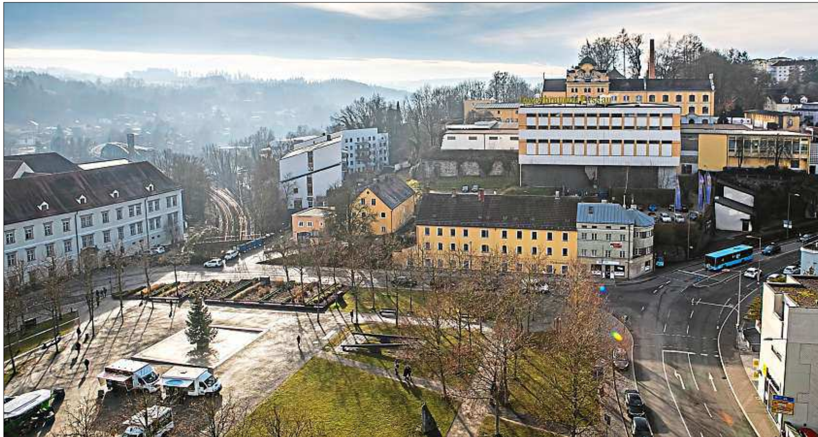
Am Fuß des Spitzbergs, unterhalb der Löwenbrauerei, werden die Gebäude weggerissen und durch Neubauten für die wachsende Uni ersetzt. Der Planungs-Wettbewerb dafür wird morgen europaweit ausgeschrieben. – Foto: Jäger
