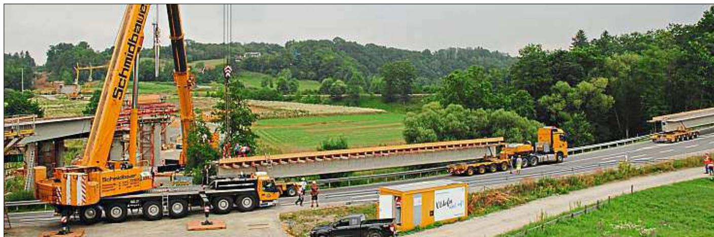
Mit Spezialfahrzeugen wurden die bis zu 100 Tonnen schweren Fertigteile von einem Ende der Stadt (Produktionsstätte Wieshof) zum anderen (kurz vor Zeitlarn) gefahren. Im Stundentakt wurden die Teile in das Brückenfeld gehoben. – Fotos: Niklas Grassl
