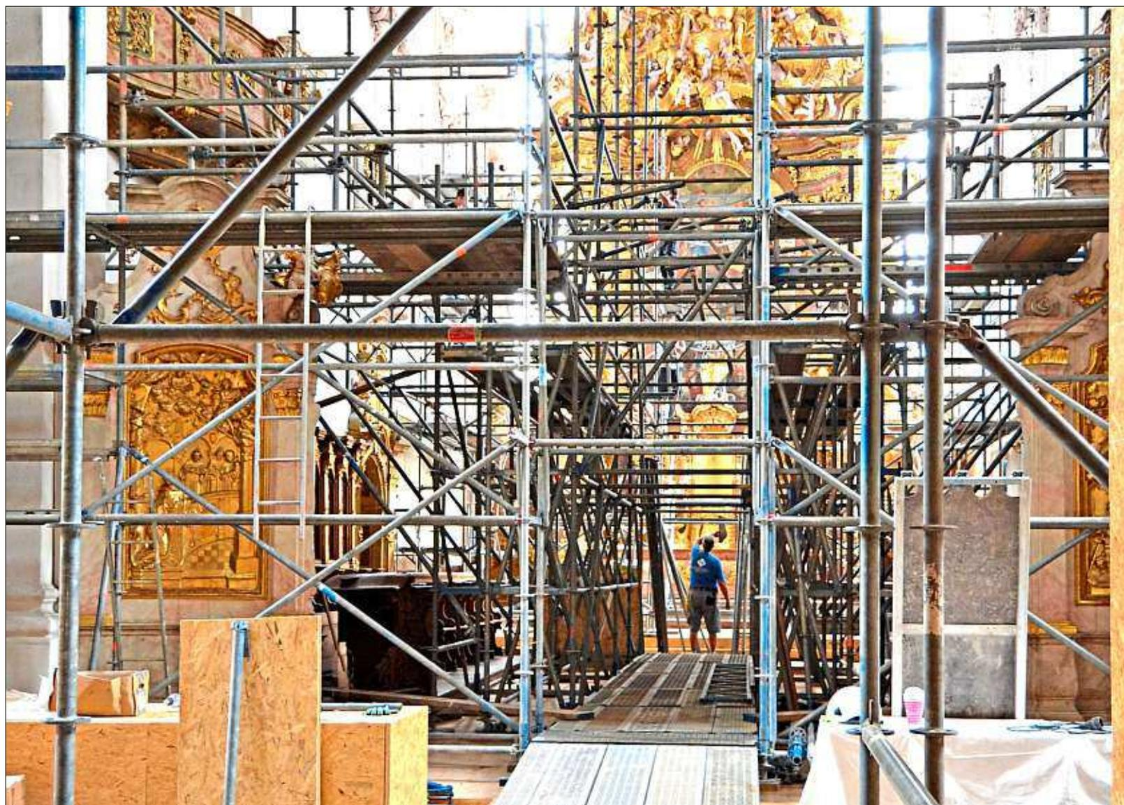
**Der Aufbau des Raumgerüsts hat begonnen:** Es dient als Arbeitsbühne für die späteren Restaurierungsarbeiten an Stuck, Putz, Fassungen und Fresken. – Foto: Felix Viemann/Staatliches Bauamt
