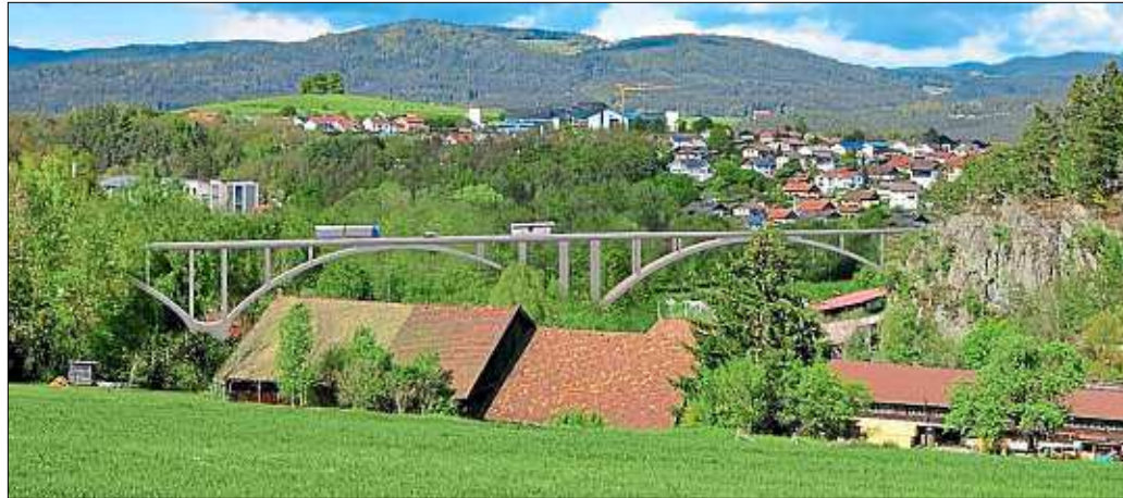
Variante 1: Eine Bogenbrücke käme mit ihrem Aussehen dem bestehenden Bauwerk näher. Diese Bauform wird vom Staatlichen Bauamt favorisiert.
