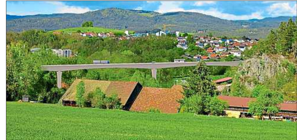
Variante 2: Auch eine Hohlkastenvariante wäre denkbar. Sie wäre weniger ästhetisch, aber ebenso funktional. – Grafiken: Staatliches Bauamt Passau
