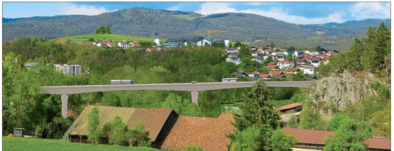
So würde die Hohlkastenbauweise aussehen.
