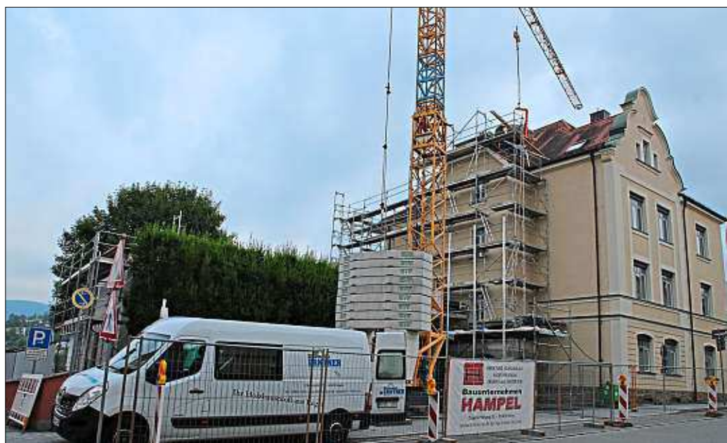
Der Erweiterungsbau des Viechtacher Finanzamtes bekommt ein neues Dach, im Altbau wird der Brandschutz verbessert. Endgültig abgeschlossen sein wird die Baumaßnahme nach Angaben von Leitendem Baudirektor Norbert Sterl, dem Bereichsleiter Hochbau des Staatlichen Bauamts Passau, erst im Herbst 2020. – Foto: Daniela Albrecht
