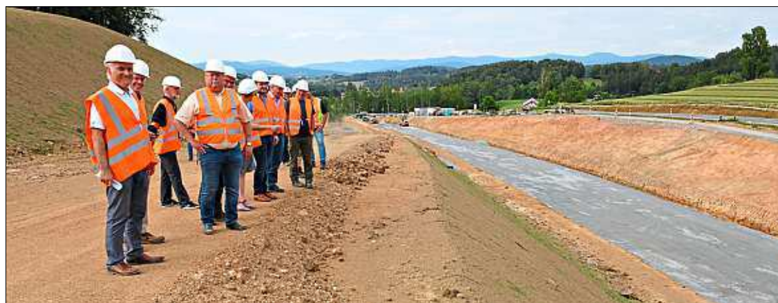
Bauamtsleiter Robert Wufka (l.) informierte zum dritten Mal im Zuge der 20-Millionen-Euro-Baußnahme die Bürgermeister der angrenzenden Kommunen vor Ort über den Baufortschritt. – Foto: Binder
