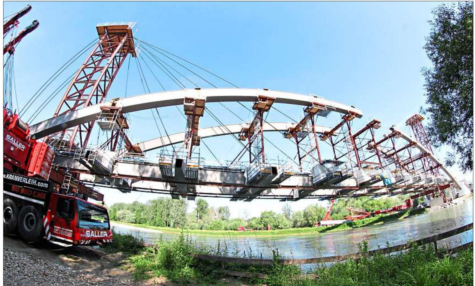
**Der Brückenbogen der Plattlinger Isarbrücke ist fast fertig:** Die Bogensegmente sind aufgelegt, in den nächsten drei Wochen finden Schweißarbeiten statt. – Foto: Staatliches Bauamt Passau
