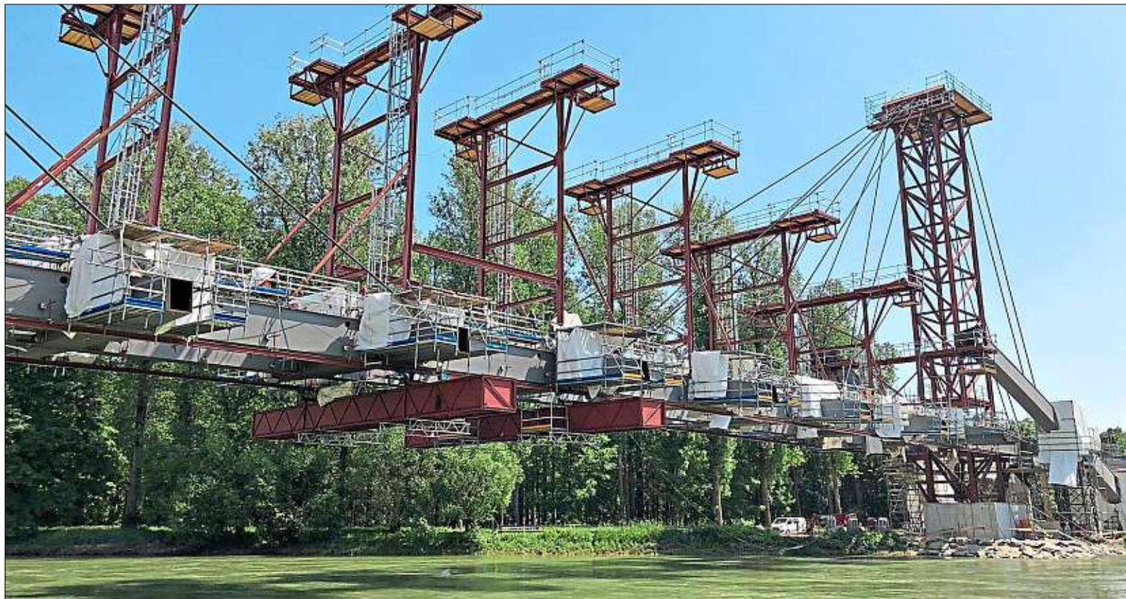
**Ab nächster Woche** werden die Bogenteile auf der Isarbrücke montiert. Die Vorarbeiten laufen – unter den weißen Einhausungen werden aktuell Schweißarbeiten ausgeführt.
