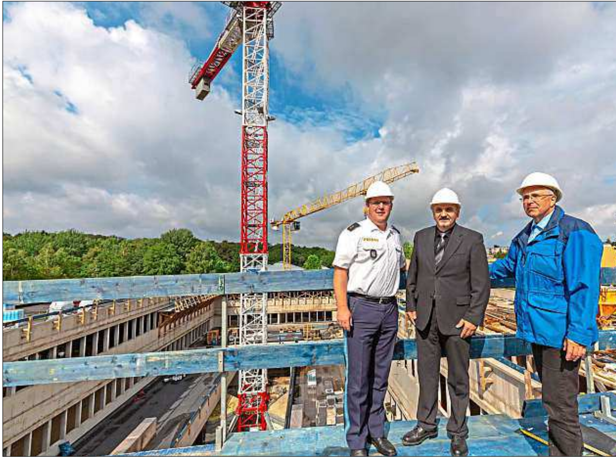
In luftiger Höhe verschaffen sich Polizeioberrat Christian Dichtl (v.l.) von der Projektorganisation Neubau Ämtergebäude Passau sowie Hochbau-Bereichsleiter Norbert Sterl und Projektleiter Gerald Escherich vom Staatlichen Bauamt Passau einen Überblick über den Baufortschritt. – Foto: Kinateder
