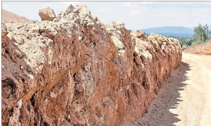
Bei den Arbeiten stößt man in Gesteinsschichten vor, die noch nie ein Menschenauge erblickte.
