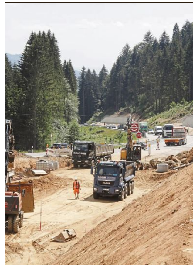
Bis zum Jahr 2021 wird die Bundesstraße B11 zwischen Grafing und Gotteszell deutlich verbreitert sowie im Bereich der Kuppe um vier Meter abgesenkt. Die Arbeiten liegen voll im Zeitplan. Fotos: pk
