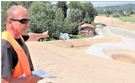
Bauführer Lothar Deuschl zeigt auf ein neues Regenrückhaltebecken.
