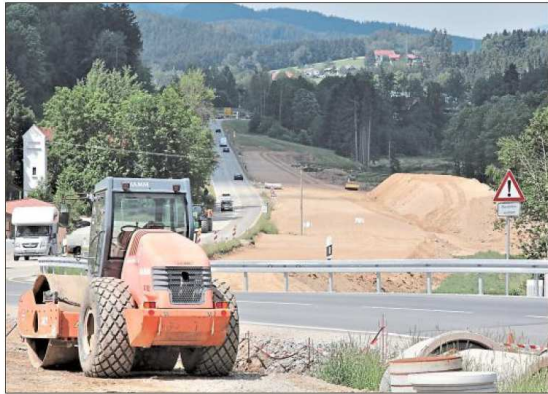
Auch in Richtung Gotteszell wird die B11 ausgebaut.
