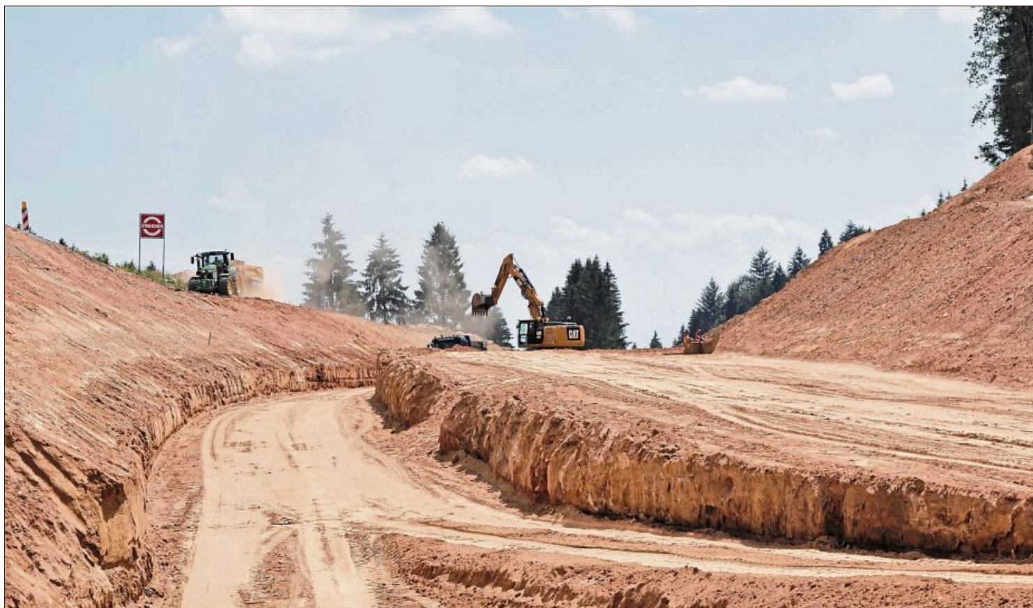
Bis zum Jahr 2021 wird die Bundesstraße B11 zwischen Grafing und Gotteszell deutlich verbreitert sowie im Bereich der Kuppe um vier Meter abgesenkt. Die Arbeiten liegen voll im Zeitplan. Fotos: pk
