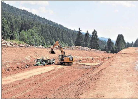
Die Kuppe bei Hochbühl ist nach den Erdarbeiten nicht wiederzuerkennen.
