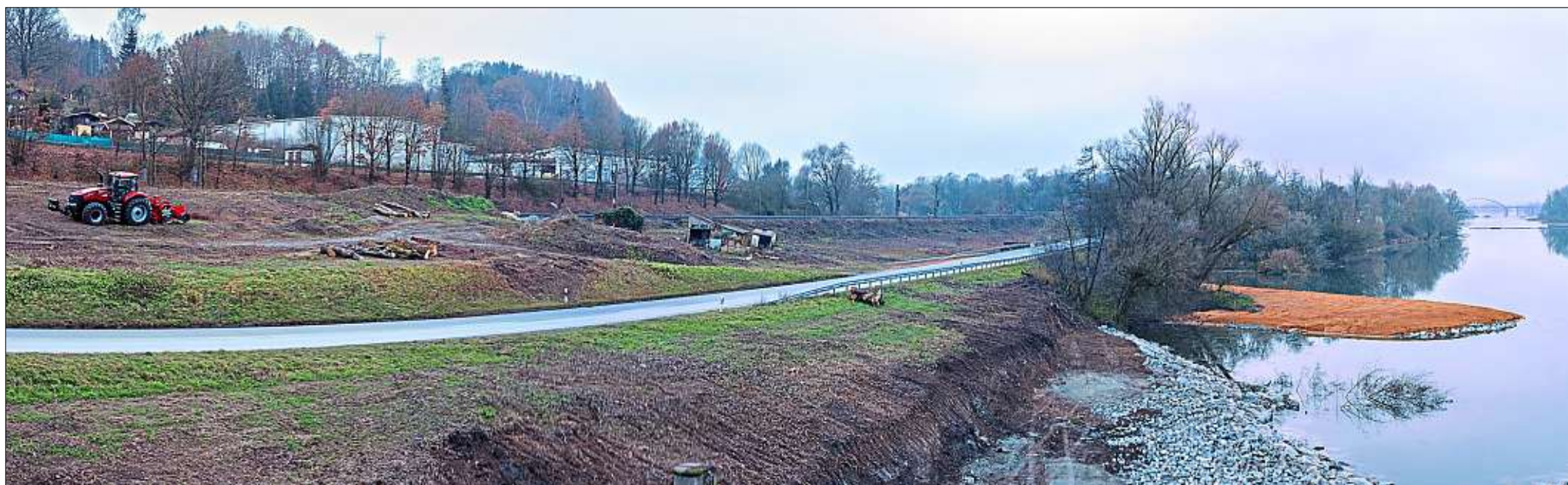
Die Umfahrung von Vilshofen ist ein Millionen-Projekt und zählt auch 2019 zu den größten Baustellen des Staatlichen Bauamts im Landkreis Passau. Ab April soll es an der B8 zwischen Witzling und Wolfachmündung mit dem Bau des Kreisverkehrs losgehen. – Foto: Laudi
