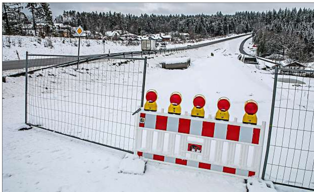
Schwerpunktthema B 12: Der dreistreifige Ausbau bei Salzweg wird heuer fortgesetzt, auf knapp zwei Kilometern Länge wird ein dritter Fahrstreifen gebaut. – Foto: Jäger
