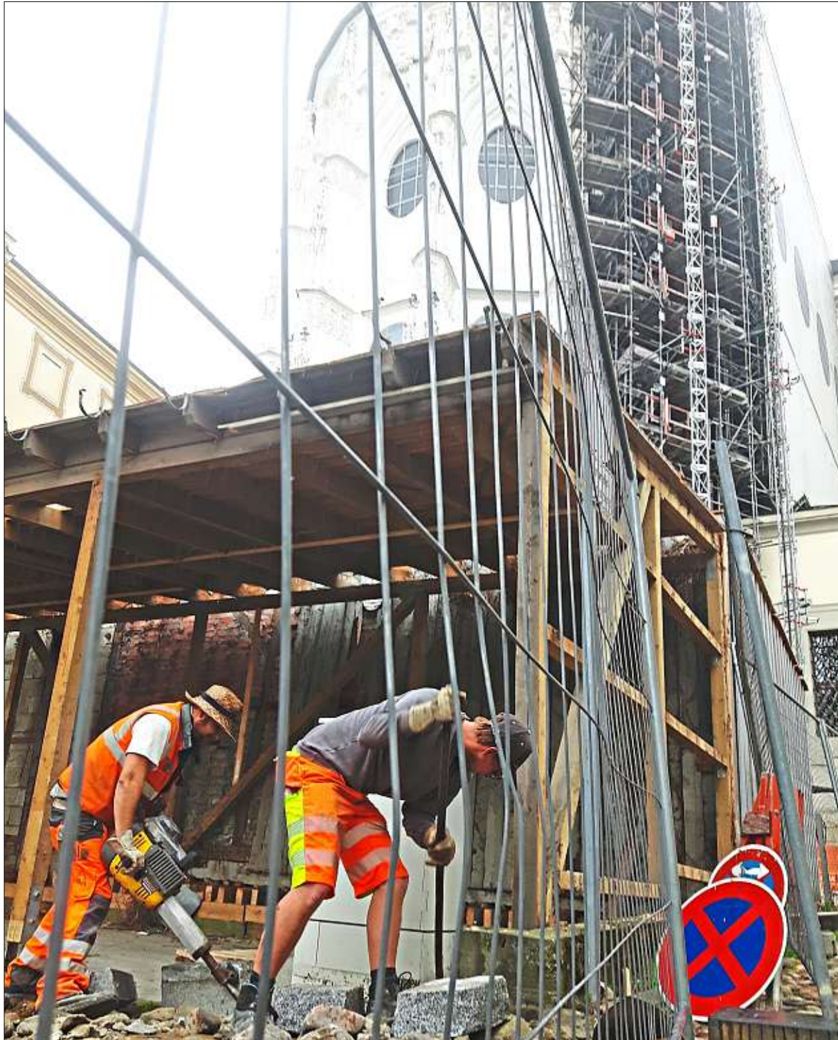
Mit Presslufthammer und Brechstange rücken Bauarbeiter den Einbauten der alten Dombauhütte zu Leibe. In acht Wochen soll hier der Neubau in die Höhe wachsen.
