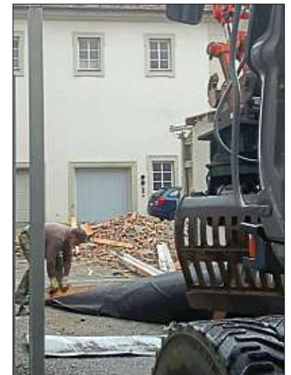
Der Bagger erledigt die größeren Arbeiten.
