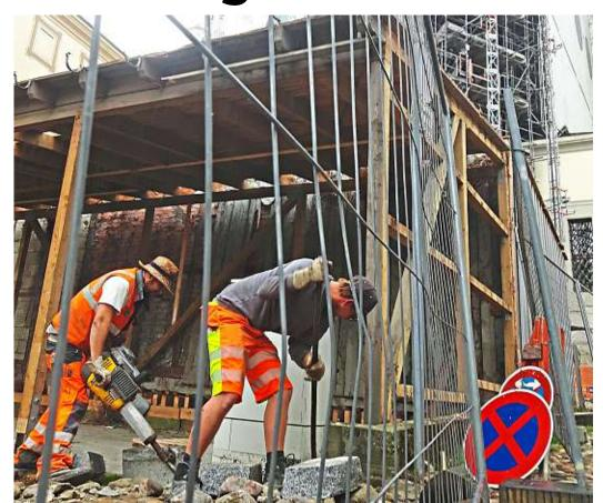
Mit Presslufthammer und Brechstange rücken Bauarbeiter den Einbauten der alten Dombauhütte zu Leibe. In acht Wochen soll hier der Neubau in die Höhe wachsen. Fotos: Danninger
