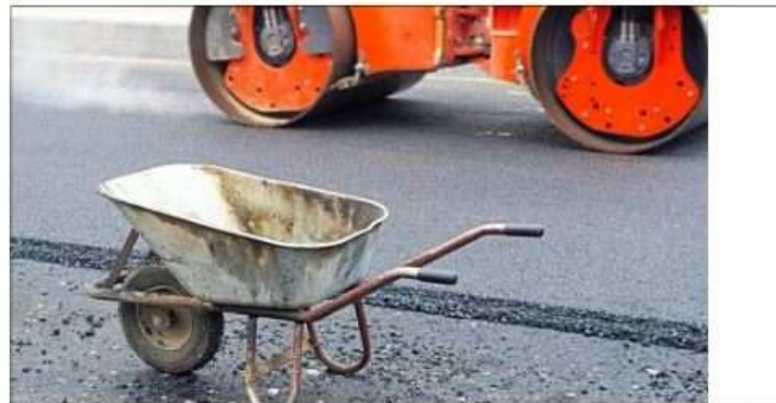
Eine Schubkarre steht an einer Straßenbaustelle. Auf der B20 ist heuer eine Sanierung geplant, eine weitere ist für das nächste Jahr vorgesehen – sofern dafür Geld zur Verfügung steht. Foto: Stefan Sauer/dpa
