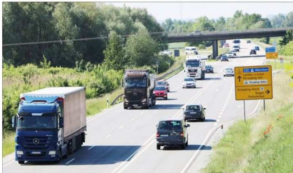
Stets viel befahren ist die B20, wie hier bei Parkstetten. Die Ausbauplanung läuft.
