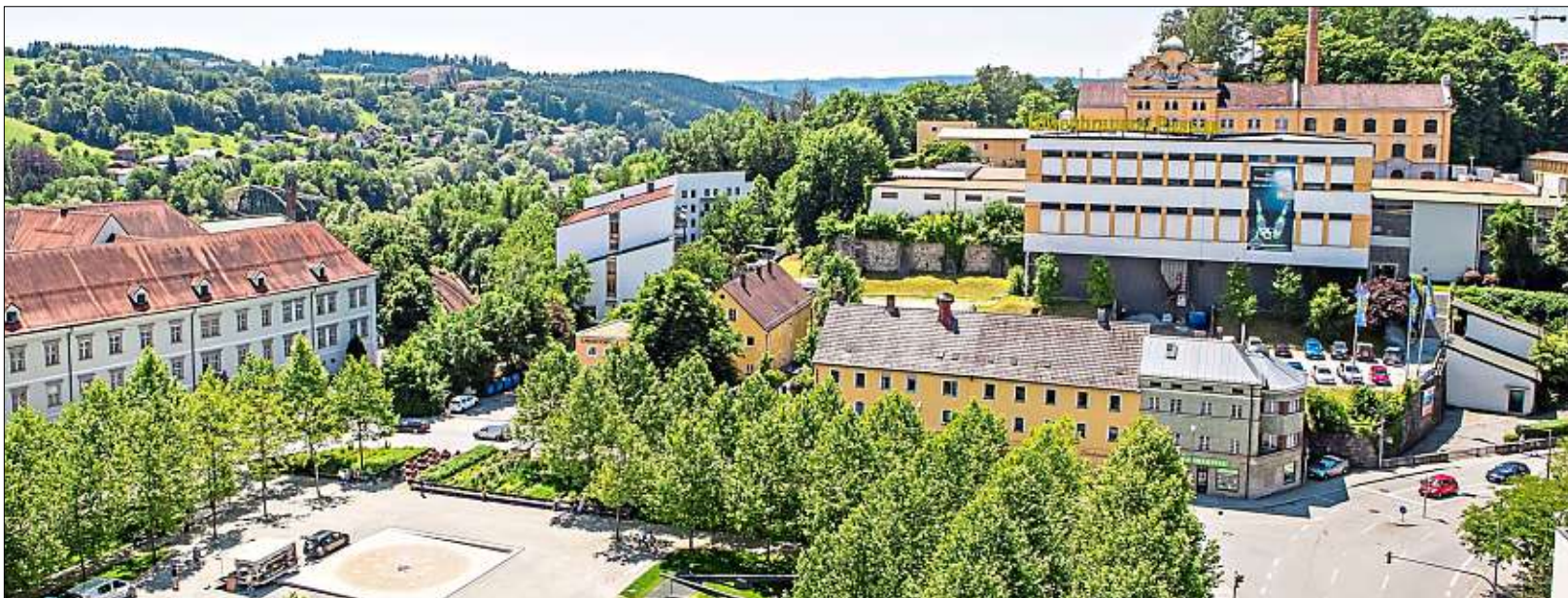
Mit Respekt vor Kloster und Brauerei sollen sich die neuen Uni-Gebäude am Spitzberg einfügen. Die Brauerei bleibt wie sie ist. Es geht um die Grundstücke zwischen Klostergarten und Abfüllanlage, wo früher unter anderem das Bräustüberl war. – Foto: PNP-Archiv
