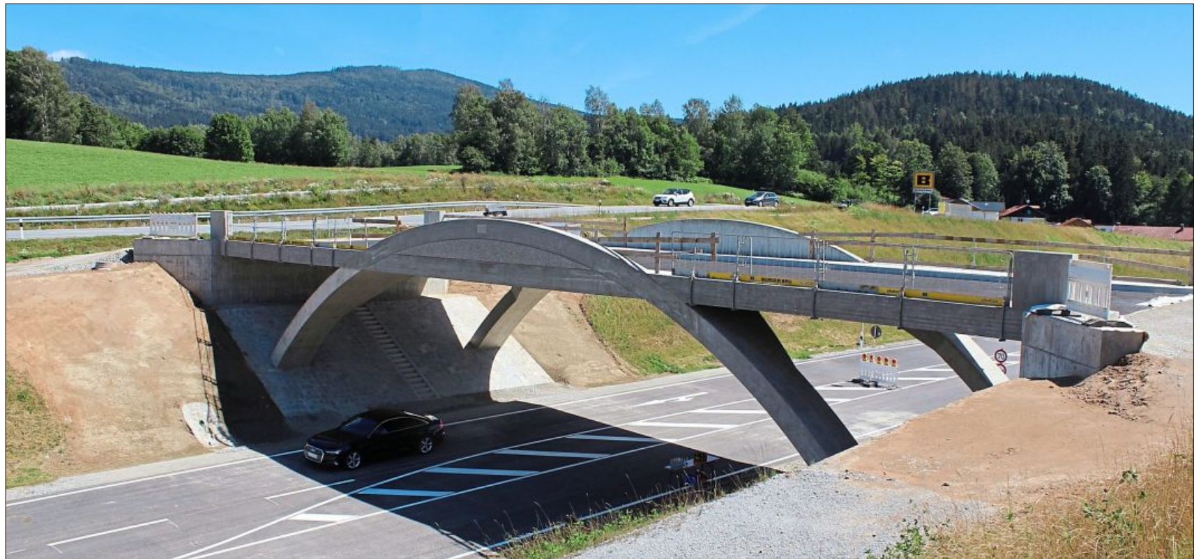
Noch zielt ein Behelfsgeländer die Brücke bei Hochbühl. Das endgültige Geländer soll im August montiert werden.
