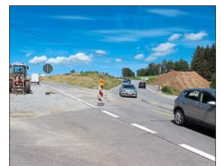
Die Behelfsumfahrung wird demnächst größtenteils zurückgebaut.
