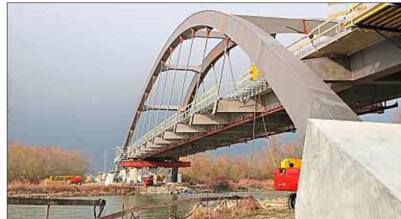
Bis zum Baustopp Anfang dieser Woche liefen die Arbeiten an der Isarbrücke auch am Wochenende – hier wird die Fahrbahnbrücke im Bogenbereich betoniert. – F.: Staatliches Bauamt Passau / Süß
