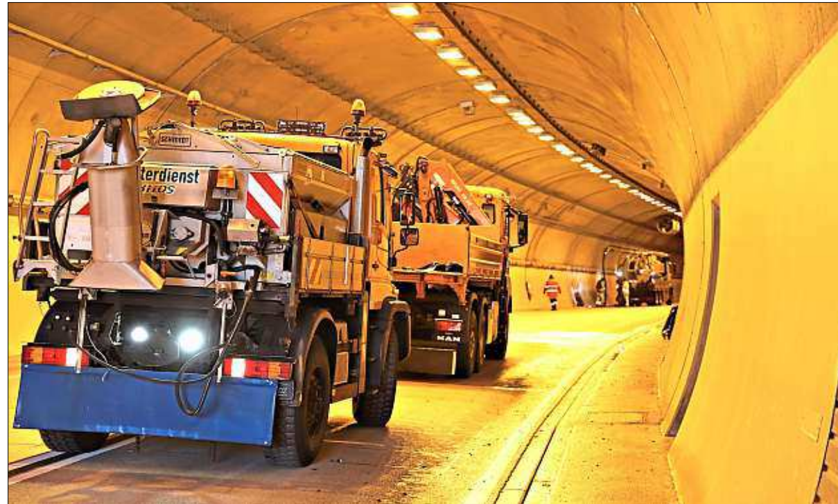
Das „team orange“ in Aktion: Während der Tunnelwartung im Riedbergtunnel in Regen reinigt die Truppe vom staatlichen Bauamt die Entwässerungsanlagen. – Foto: Staatliches Bauamt
