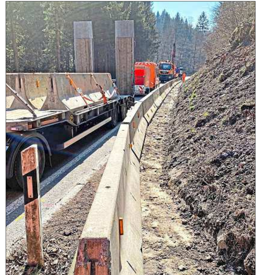
Nach einem Steinschlag stellen die Mitarbeiter der Straßenmeisterei Vilshofen Betongleitwände entlang der Staatsstraße 2172 bei Doblmühle, Markt Windorf, auf. – Fotos: PNP
