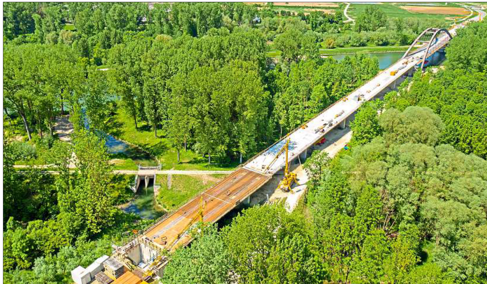
Aus der Luft ist das hellgraue Band der betonierten Fahrbahnplatte gut zu erkennen.
