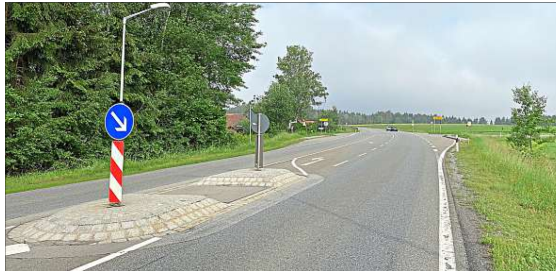
Auf Höhe Ayrhof kreuzen sich die Bundesstraße 85 und die Kreisstraße REG 19. Das Staatliche Bauamt Passau will die gefährliche Kreuzung nun entschärfen – mit Hilfe einer Brücke unter der die Kreisstraße durchgeführt werden soll. – Foto: Lea Arbingner
