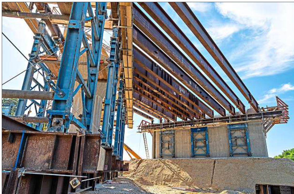
Tonnenschwere Stahlträger werden mit Autokränen an ihre Position gehievt. Sie bilden das Traggerüst für die Schalung. Es gibt keine Fertigteile. Der Überbau wird an Ort und Stelle betoniert.
