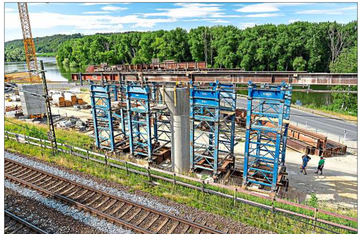
Die drei Pfeiler zwischen den beiden Widerlagern können während des Baus die Konstruktion nicht tragen, weswegen Stützen aufgestellt werden, die später wieder verschwinden. Im Hintergrund die Donau.
