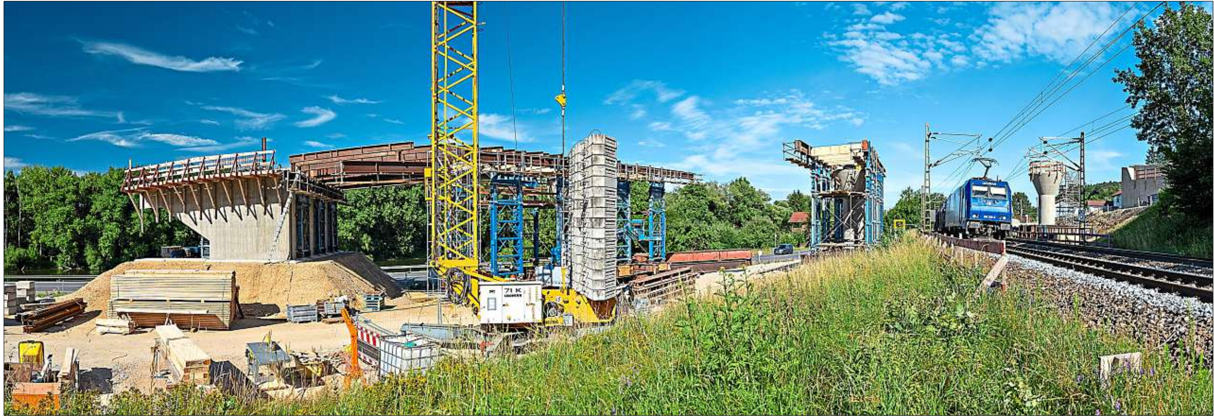
Die mächtige Baustelle in der Übersicht: Links das erste Widerlager der 82 Meter langen Brücke, am rechten Bildrand hinter dem Baum lässt sich das andere Widerlager erkennen. Dazwischen ruht die Brücke auf drei Pfeilern, die durch ihre Trichterform einen architektonischen Akzent setzen. Die Baustelle befindet sich zwischen der Donau (links) und dem Galgenberg und überquert die Bahnlinie Plattling - Passau. – Fotos: Georg Laudi
