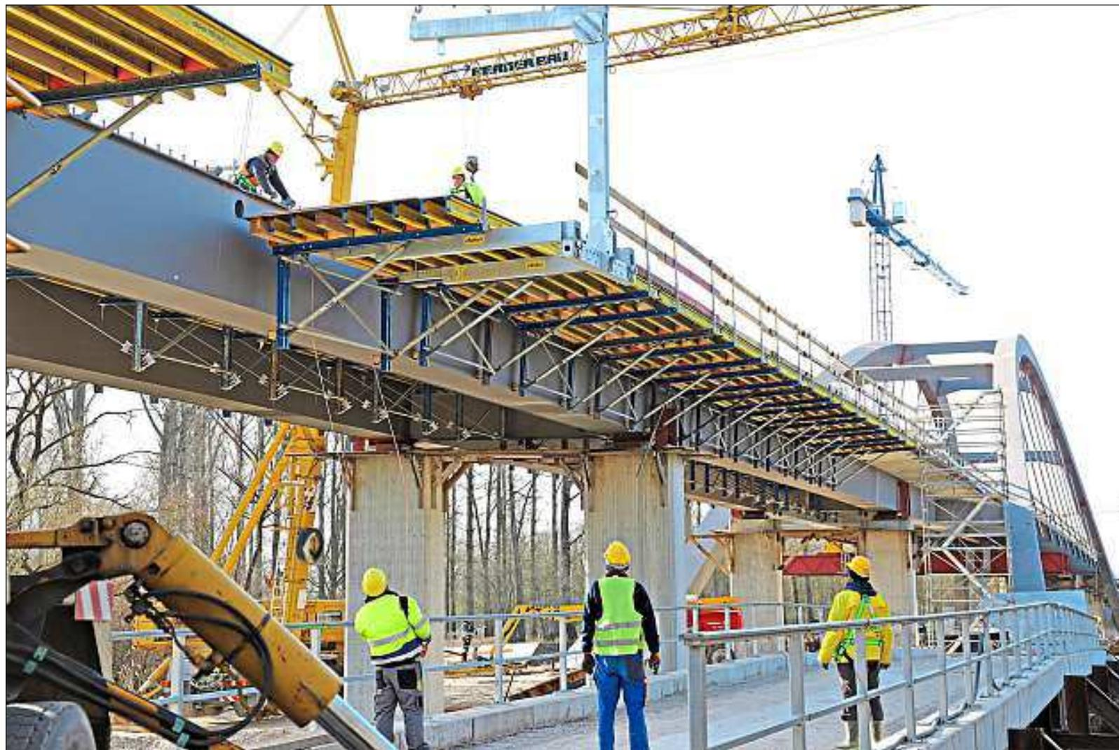
**Die Arbeiten an der Isarbrücke** gehen wieder mit Hochdruck weiter: Am Freitagvormittag wurden die Schalungsteile für das Betonieren der Fahrbahnplatte eingesetzt. – Foto: Staatliches Bauamt Passau / Süß
