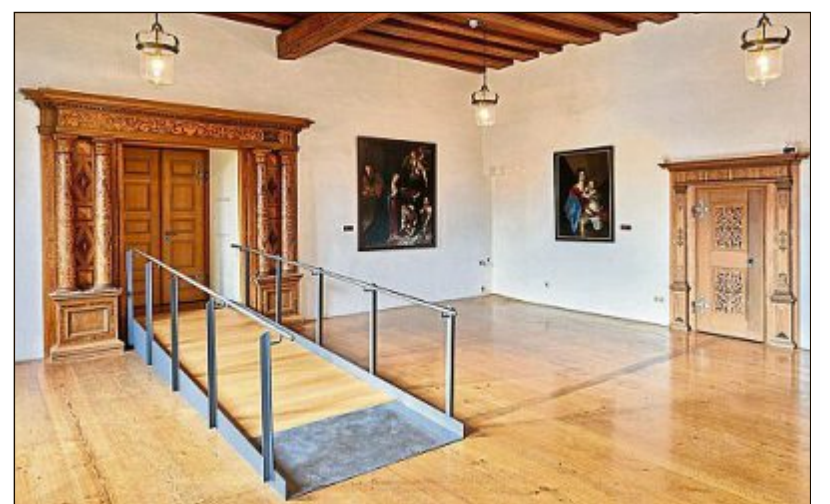
Das barrierefreie WC im Erdgeschoss. Eine mobile Rampe im Vorraum erschließt behindertengerecht den Rittersaal.
