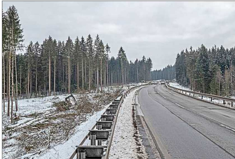
2,6 Hektar Wald gerodet haben Forstarbeiter jüngst im Auftrag des Staatlichen Bauamtes Passau. Der gewaltige Eingriff in die Natur erfolgte, um die Bundesstraße 85 an dieser Stelle um eine dritte Fahrspur bergauf erweitern zu können, erklärt die Baubehörde. Im Gegenzug würden umfangreiche ökologische Ausgleichsmaßnahmen im Brandtner Moor bei Langdorf vorgenommen. – Fotos: Klaus-Dieter Neumann
