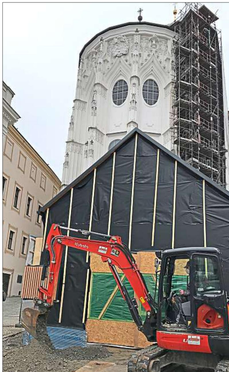
**Vor der neuen Dombauhütte** wird gerade gebaggert. Die Entwässerungsanschlüsse sind an der Reihe.
