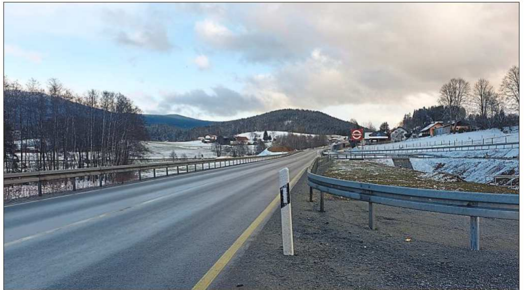
Die Winterpause ist fast vorbei, bald wird hier wieder gearbeitet.
