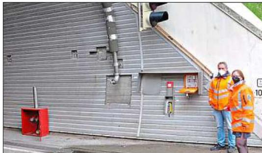
**Am Tunneleingang** zeigen Bernd Kufner und Sabine Süß, wie die Beleuchtung und Belüftung manuell umgestellt werden kann. Der Löschwasserzugang muss erst wieder angeschlossen werden.
