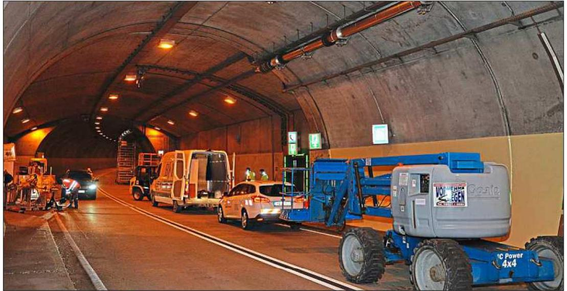
**Schweres Gerät** zur Erhöhung der Sicherheit im Riedbergtunnel. Rechts unter der Decke verläuft die isolierte und ummantelte Löschwasserleitung. Die helle Fassade im unteren Bereich der Röhre wurde an dieser Stelle erneuert. – Fotos: Baumgartner
