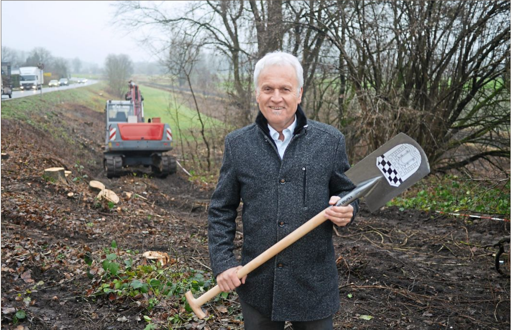
Seit 2004 leitete Robert Wufka das Staatliche Bauamt Passau, seit Anfang des Jahres ist er nun im Ruhestand. Unser Bild zeigt ihn bei seinem letzten Spatenstich im Amt in Halbmehle bei Deggenndorf, wo eine Radweg-Unterführung für mehr Sicherheit sorgen soll. Foto: Peter Kallus
