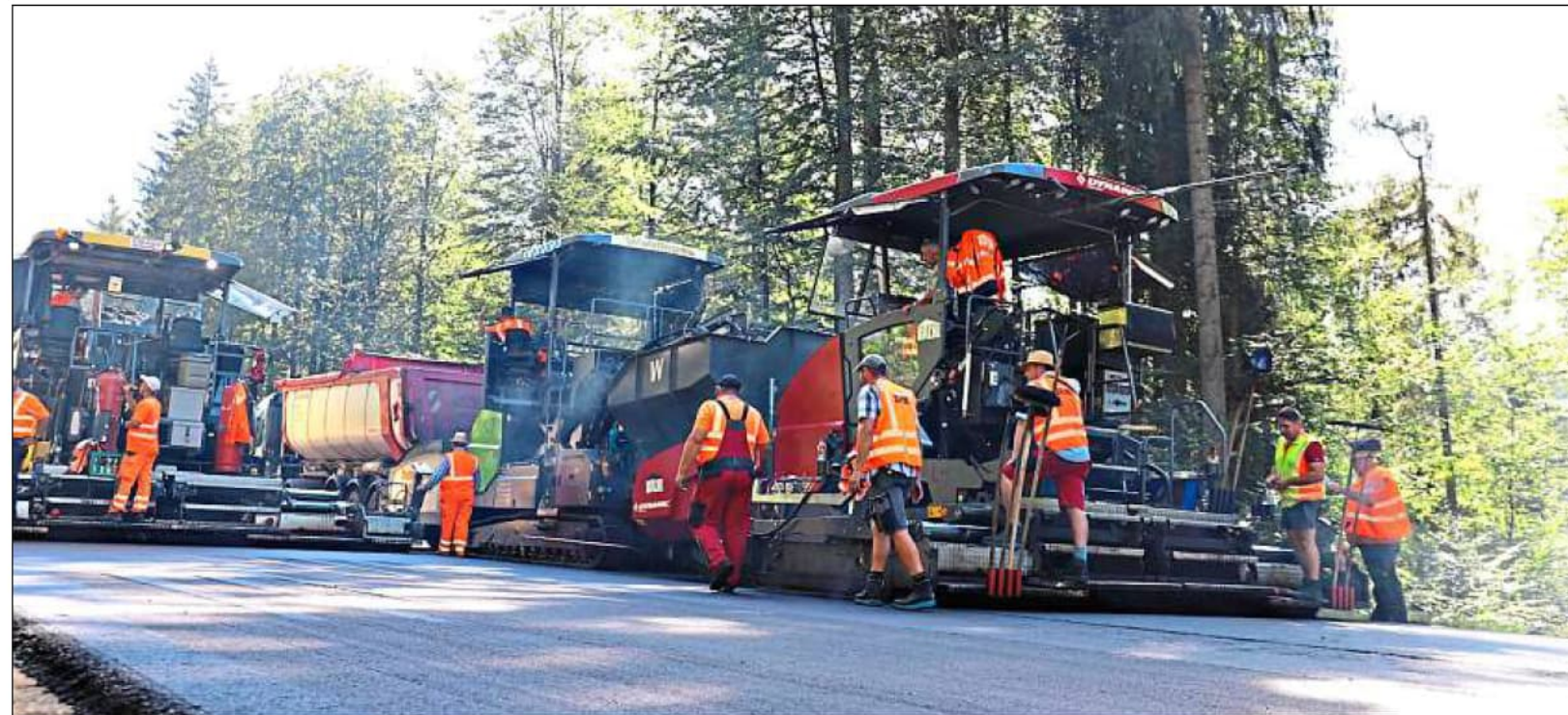
Zwischen Herzogsreut und Philippsreut wurde die Fahrbahndecke auf der B 12 neu asphaltiert, zudem wurde die sogenannte Schwarzkopfcurve entschärft. – Fotos: Staatliches Bauamt Passau
